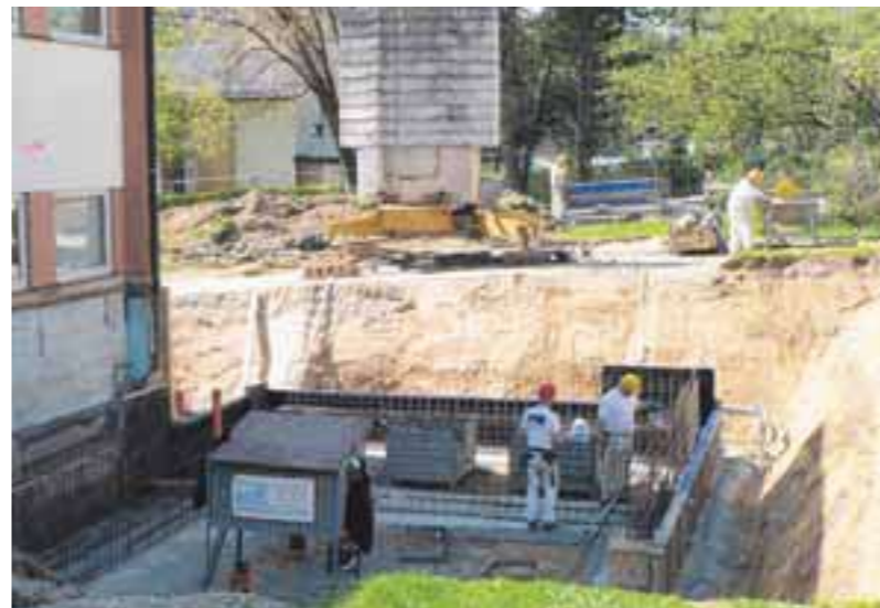
Noch sieht man wenig von dem bald dreigeschossigen Anbau an die Süd-West-Ecke der Straßberger Grundschule.
